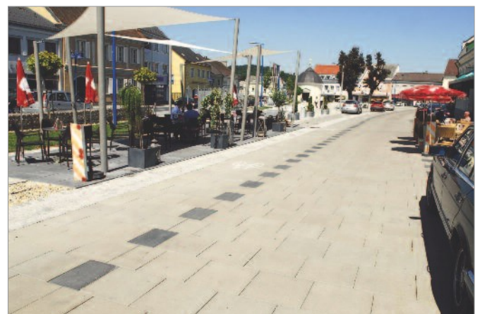
Bild 2: Nur bei einer regelgerechten Fugenbreite können Betonsteine bei Aufgrabungen aus der Fläche genommen und wieder verlegt werden.
