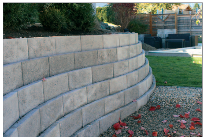
Bild 4: Geschwungene und versetzte Böschungssteinwand
