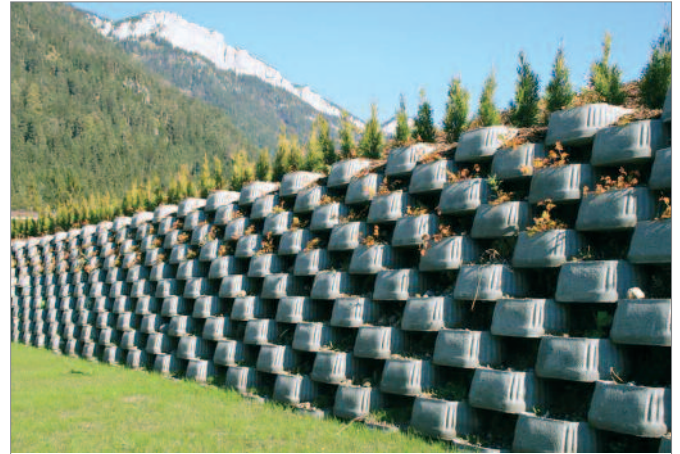
Bild 7: Weitläufige Wand mit bepflanzen Böschungssteinen
